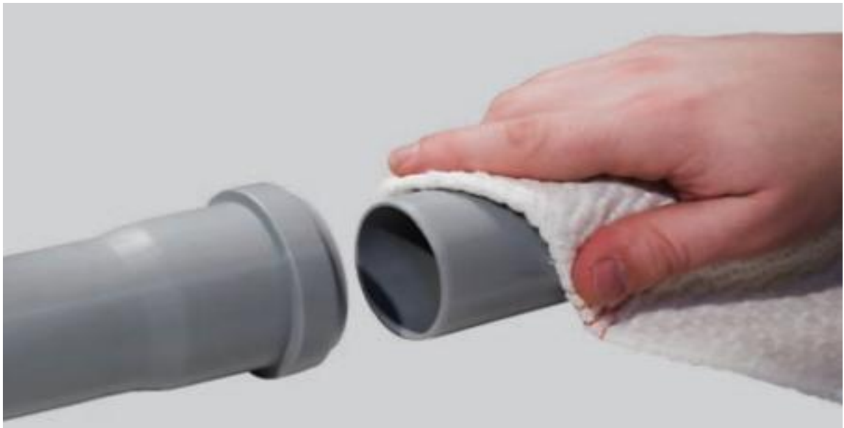
Рисунок 1.5 - Подготовка труб к склеиванию
